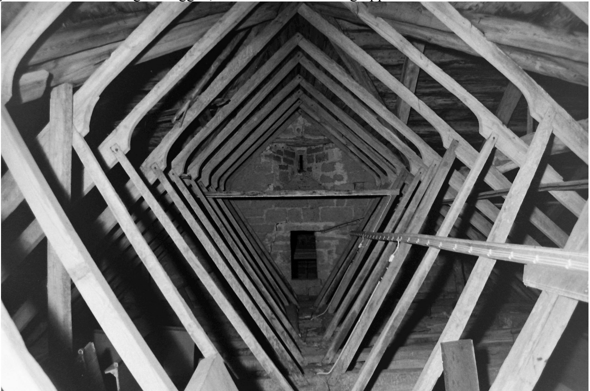
Bild 18. Långhusvinden med de medeltida takstolarna, sedd mot öppningen till korvinden.
