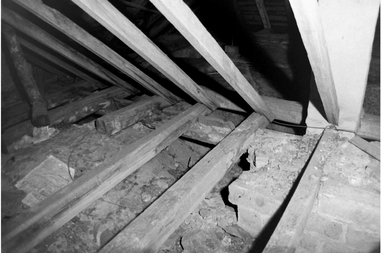
Bild 19. Fotot taget från långhusets mitt mot södra tvärskeppet. Bilden visar kvarvarande ursprungligt väggparti ovanför pelaren mellan långhuset och södra korsarmen. Skorstenen till höger står på den nya pelarhalvan mot tvärskeppet. Notera de ursprungliga hammarbanden och takstolarna. Notera även skarven mellan långhusets äldre valvkappa och tvärskeppets yngre valvkappa vid ändan på den avkapade hanbjälken och ner mot väggpartiet.
